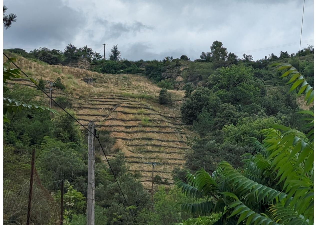
Chantier de phytostabilisation en cours à Saint-Laurent-Le Minier Photographie de l'auteure
