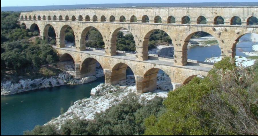
Pont du Gard, France, 35 000 blocks
