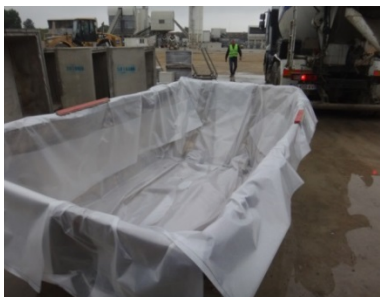
J-0 Coulage – bennes de 4 m 3
