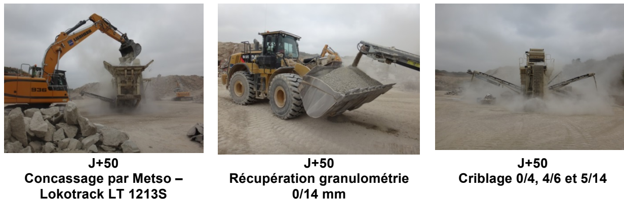
Figure 3 : Processus de concassage des bétons parents - usine Mialanes/Biocama à Pignan
